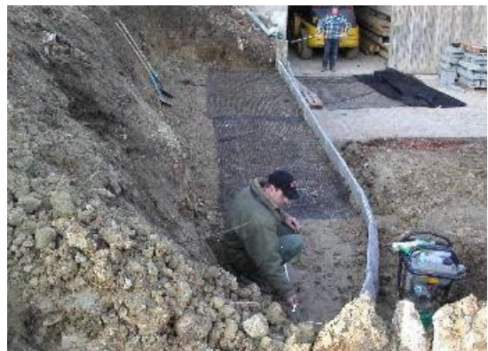
Bild 24: Verlegen der Geogitter, seitliche Überlappung 20 cm
