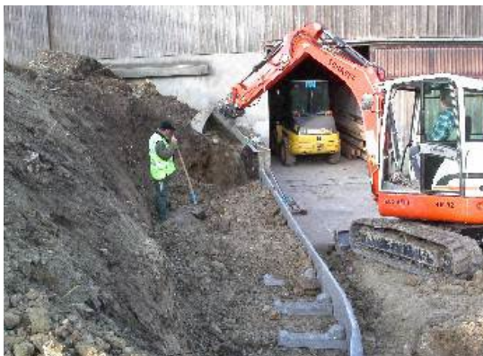
Bild 20: Hinterfüllen der ersten 20 cm
