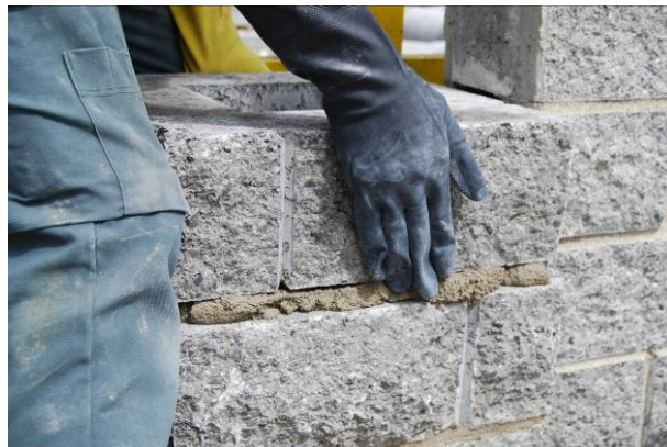
Bild 59: Versetzen von Pfeilerspaltsteinen
