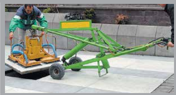
PRESTO APPAREIL DE POSE POUR DALLES
