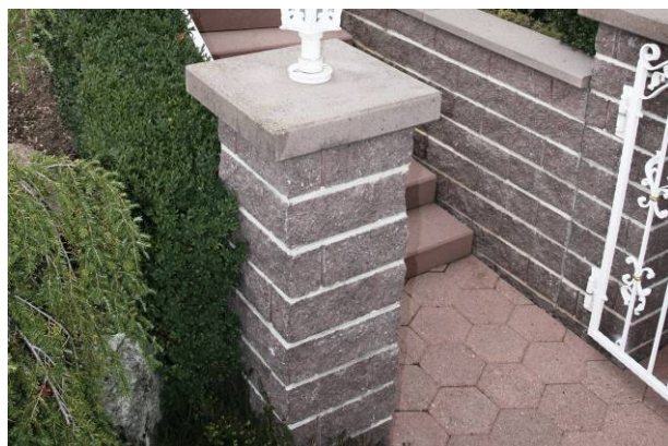
Bild 4: Versetzte Pfeilerspaltsteine
