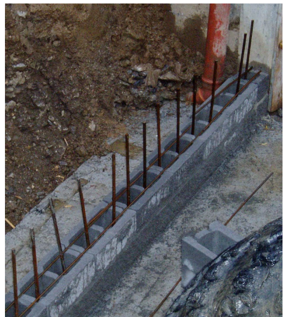
Bild 11: Horizontale und vertikale Bewehrung (Produktneutral)
